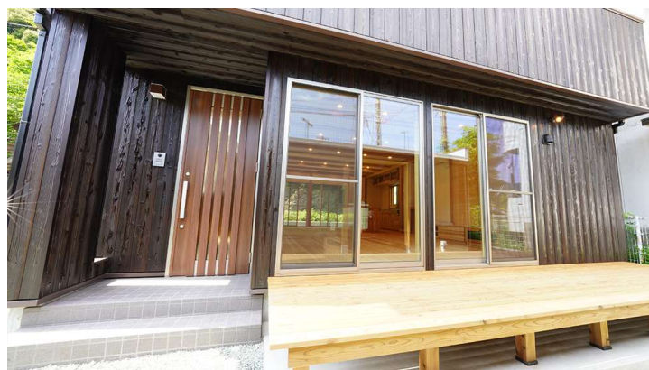
南向きのウッドデッキ
