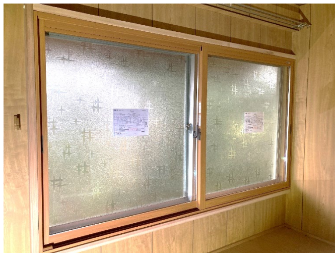
内窓サッシを設置した窓
