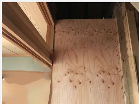
構造用合板の設置
