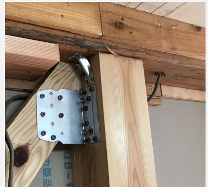
構造金物を柱の脚に設置
