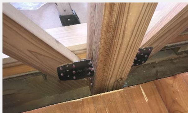
構造金物を柱の脚に設置
